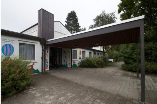
Grundschule an der Ittlingerstraße Ittlingerstraße 36 80933 München
