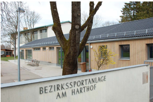
Sportanlage der Balthasar-Neumann- Realschule (Wegenerhalle) Wegenerstraße 8 80937 München
