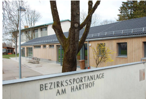
Sportanlage der Balthasar-Neumann- Realschule (Wegenerhalle) Wegenerstraße 8 80937 München
