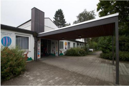
Grundschule an der Ittlingerstraße Ittlingerstraße 36 80933 München
