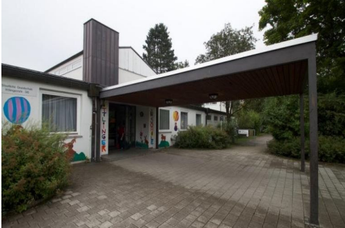
Grundschule an der Ittlingerstraße Ittlingerstraße 36 80933 München
