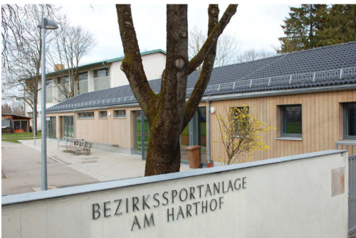
Sportanlage der Balthasar-Neumann- Realschule (Wegenerhalle) Wegenerstraße 8 80937 München
